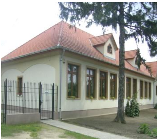
Csikériai Általános Iskola felújított épülete
